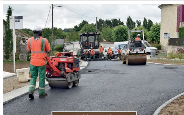
Pose enrobé devant la mairie
